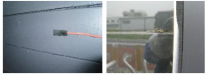
写真4 . 雨で濡れたスリット 写真5 . ホコリが溜まったスリット吸込式集熱面
