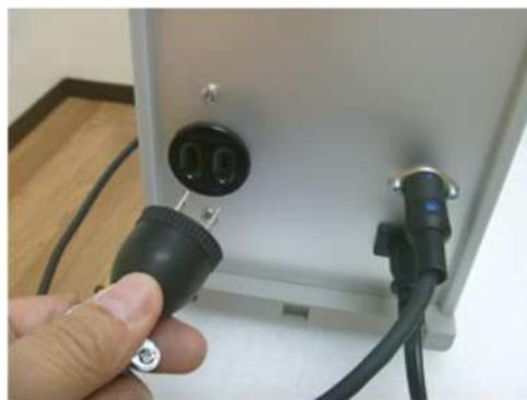
⑩ ファンの電源コードをインバータボックスのファン用電源コンセントに差す。
